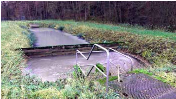
Alte Kläranlage bei Unterbreitenlohe Foto J. Schrenk
