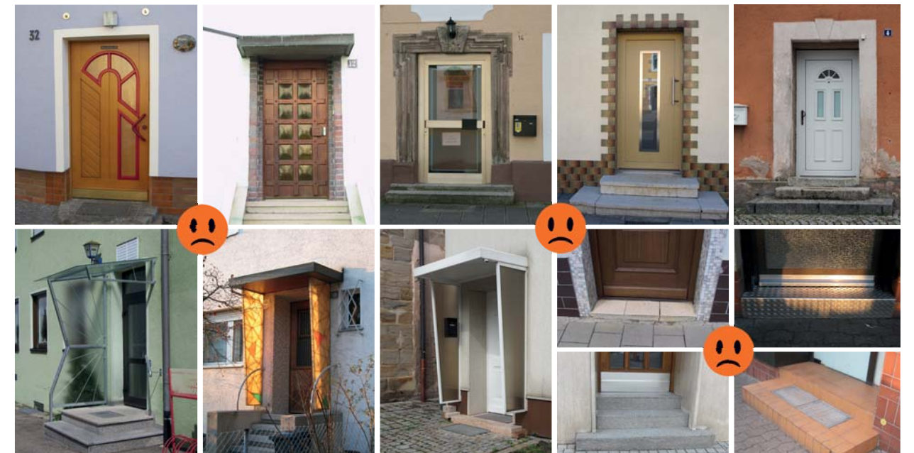
Metall-Glas-Türen, Drahtglas, farbige Glasflächen, stark glänzende Oberflächen oder moderne Kunststofftüren werden historischen Gebäuden nicht gerecht. Untypische Fliesenrahmungen anstelle eines Natursteingewändes sind genauso negativ zu werten wie der Einbau neuer Türen in historische Türrahmungen, der Einbau von Windfang und Vordach sowie moderne Belagsmaterialien auf der Türschwelle und Treppe ohne Rücksichtnahme auf den historischen Bestand.
