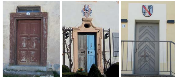
Historische Türen sind in Röttenbach nur vereinzelt zu finden. An leerstehenden Gebäuden oder an Gebäuden von besonderer Bedeutung wie Pfarrhaus finden sich alte Türen, die die historische Bautradition zeigen. Die Alte Schule in der Deutschhermstraße ist ein gutes Beispiel für die angestrebte Gestaltung im Sinne des Förderprogramms.
